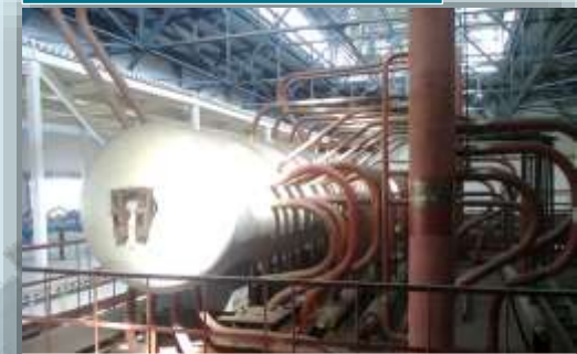
Обвязка барабана котла E-50 3,9 440
