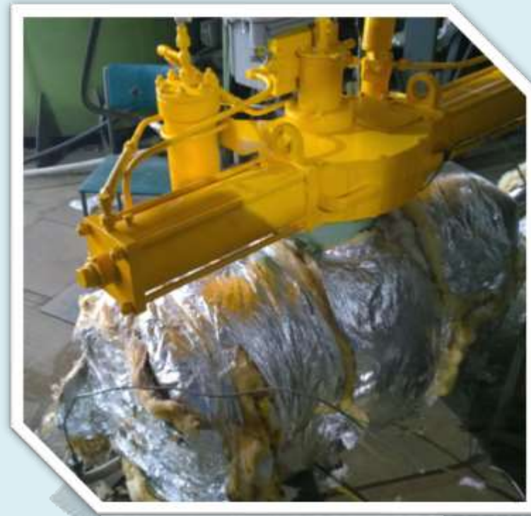
Шаровой кран DN 300, PN 10 МПа
