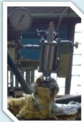
Клапан с пневмоприводом типа 33Т С965
