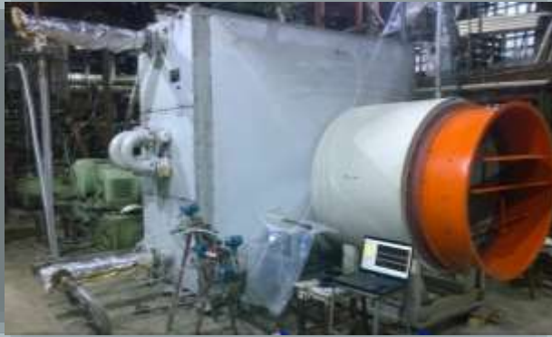
Рециркуляционная установка вентиляции РУВ-60 для Нововоронежской АЭС-2
