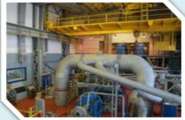
Экспериментальная Турбина Низкого Давления (ЭТНД-2)
