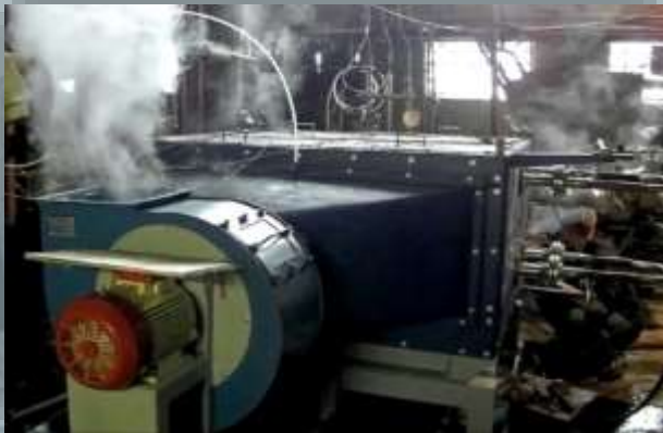
Рециркуляционная охлаждающая установка РОУ-6,3 ЭМК.0155.000.00.00 для третьего блока Ростовской АЭС (имитация аварийного режима)
