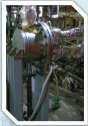
Теплообменник системы обработки газовых сдувок KKS 10KPL11AC002 со сварным пакетом пластин Plate Stack XPSP 50 для Белорусской АЭС
