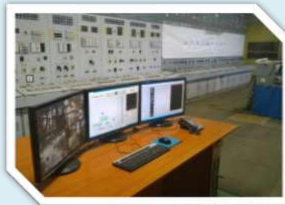
Пульт управления Комплексного стенда КС10606
