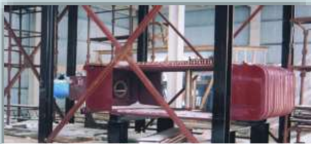
На стадии монтажа
