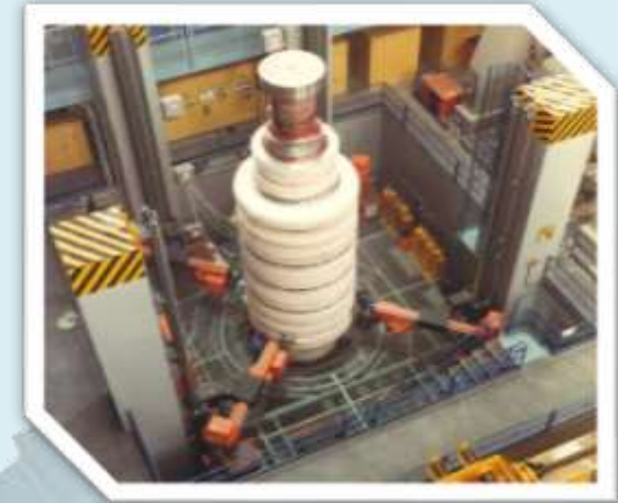
Сварка корневой части сварных соединений ротора
