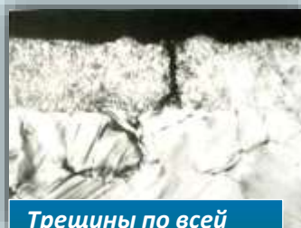
Трещины по всей толщине
