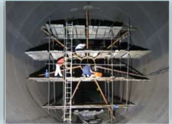
Установка вертушек в водоводе
