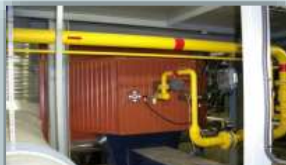
растопочное устройство котла КЕ-25-24-350
