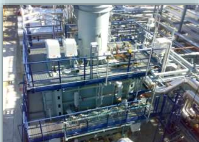
Система ГИО на установке ИЗОМАЛК-2 АО «Газпромнефть – Омский НПЗ», 2011 г.
