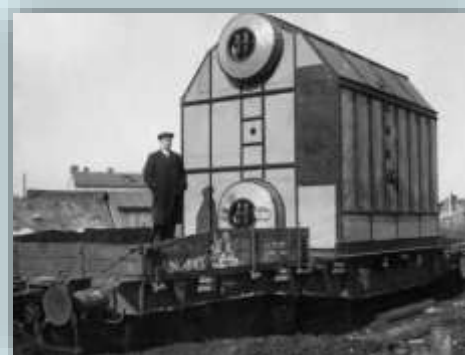
Головной образец транспортабельного котла системы ЦКТИ ТК-3-13
