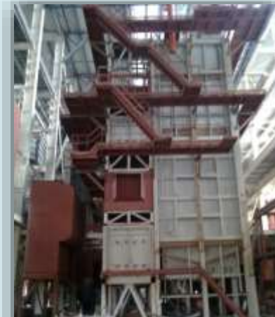
Монтаж парового котла E-50 3,9 440
