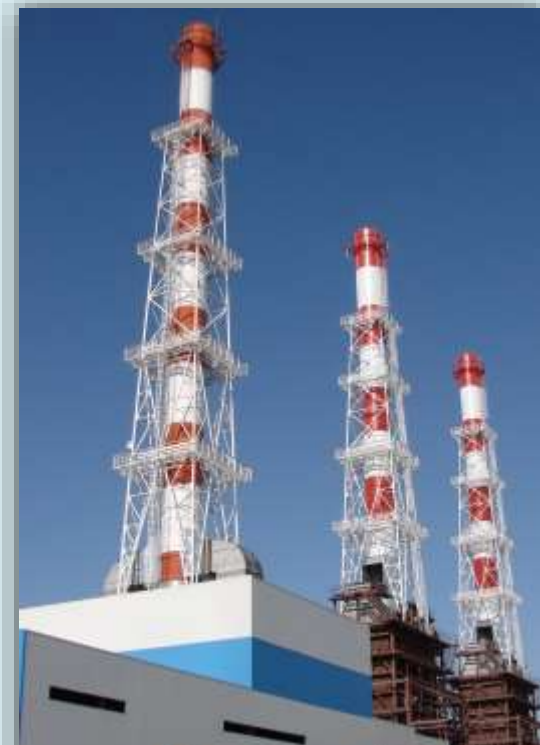
Каркас энергетического котла и башня для дымовой трубы
