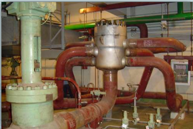
Общий вид смонтированного агрегата насосного КГТН 850-400А до установки теплоизоляции
