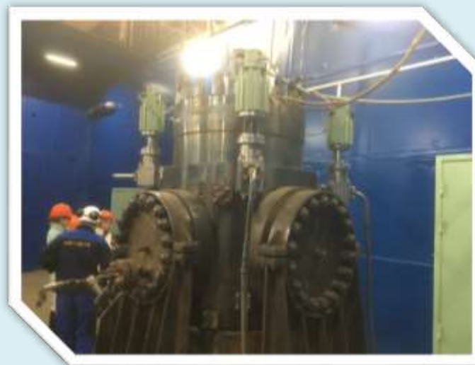
Одна из испытательных отметок комплексного стенда КС10606 Вид на установленные на стенде БЗОК- 600 и ИПУ ПГ.
