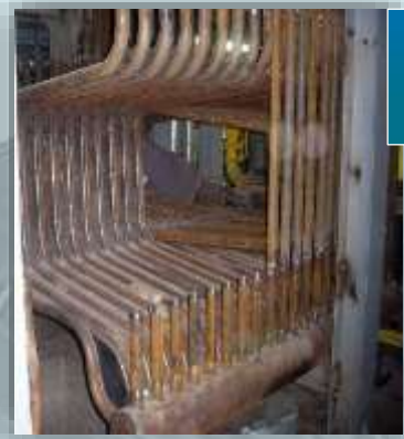
Котлы со ступенчатой решеткой с переталкивающими шурующими планками - решение для котлов малой производительности, сжигающих топлива биологического происхождения ухудшенного качества
