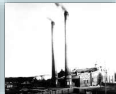
Центральная электрическая станция городских железных дорог. Вид со стороны Кременчугской ул. 1907 г.
